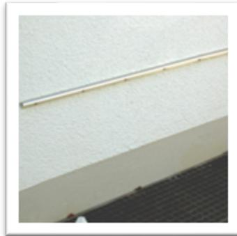
Wandleiste mit passenden Dübeln und Schrauben befestigen und Wandseitig mit Silikon abdichten !
