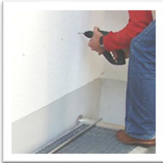
Löcher für Wandleiste bohren – mit Wasserwaage kontrollieren!
