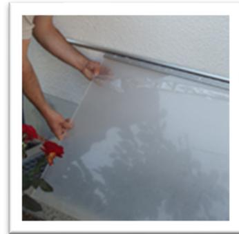
Abdeckung mit Doppel-Kederband in die Wandleiste einziehen.
